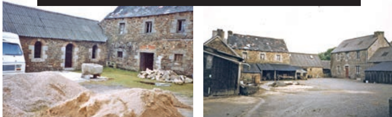
LE CORPS DE FERME (EN 2002) AVANT ET PENDANT LES TRAVAUX
